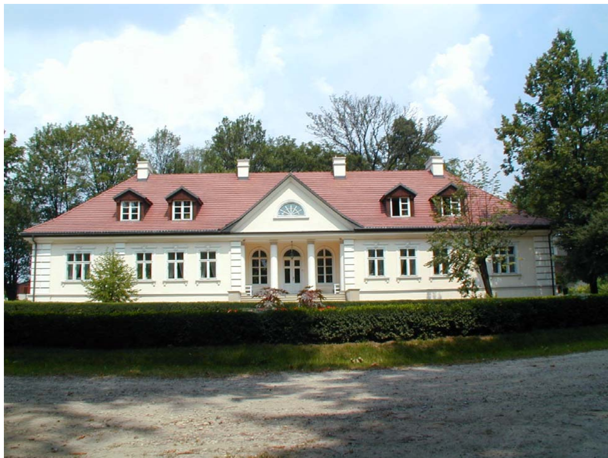
Rysunek 1: Budynek Dworu (fot. D. Poplawski)
